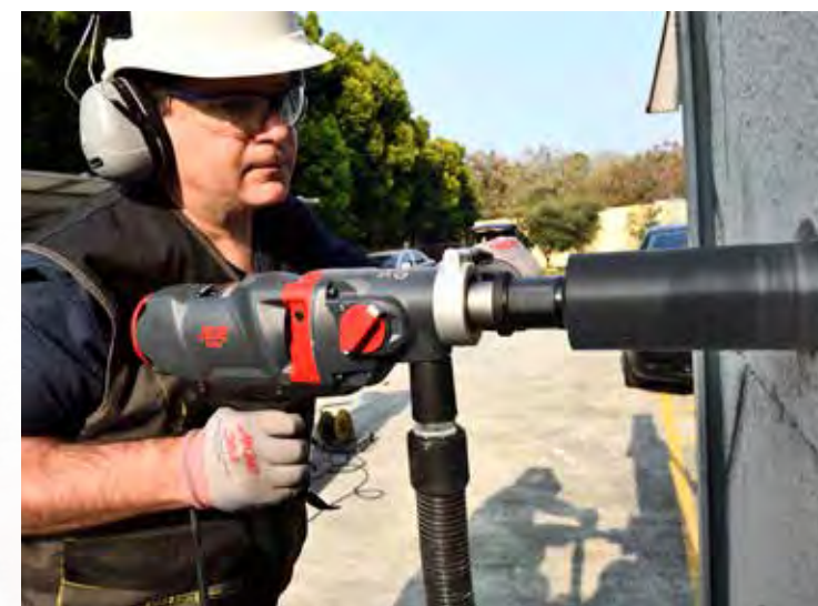
Diamantboorkronen geschikt voor droog gebruik in (gewapend) beton
